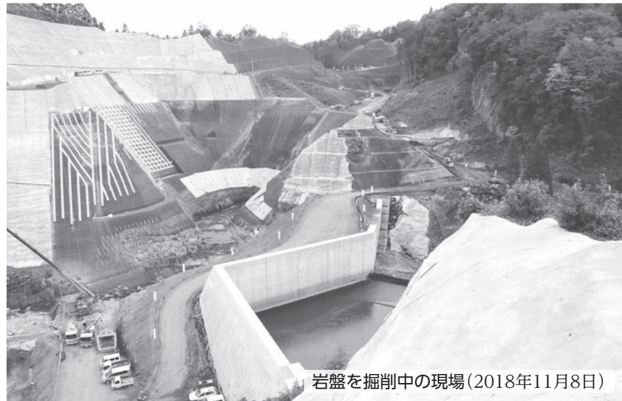
岩盤を掘削中の現場(2018年11月8日)
