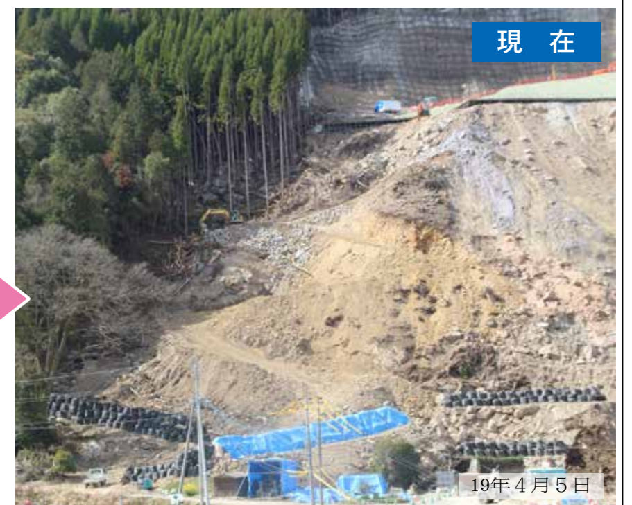
中津市が民家を撤去し、斜面左側でコンクリート土留工が始まる
