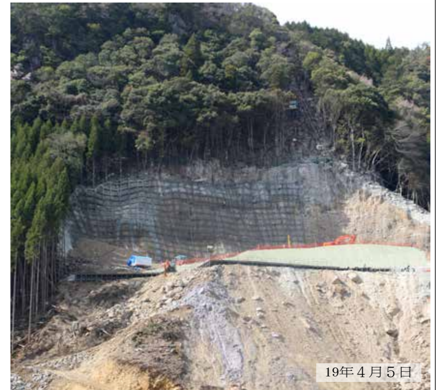
山頂部で進むアンカー工事
