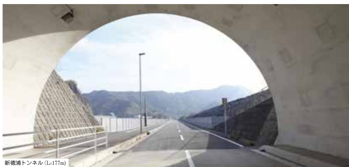
新徳浦トンネル(L=177m)
